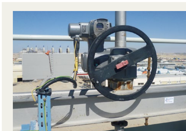
Bild 1: Die Stellantriebe in Industrieanlagen müssen hoher Belastung standhalten und erfordern einen sehr guten Korrosionsschutz
