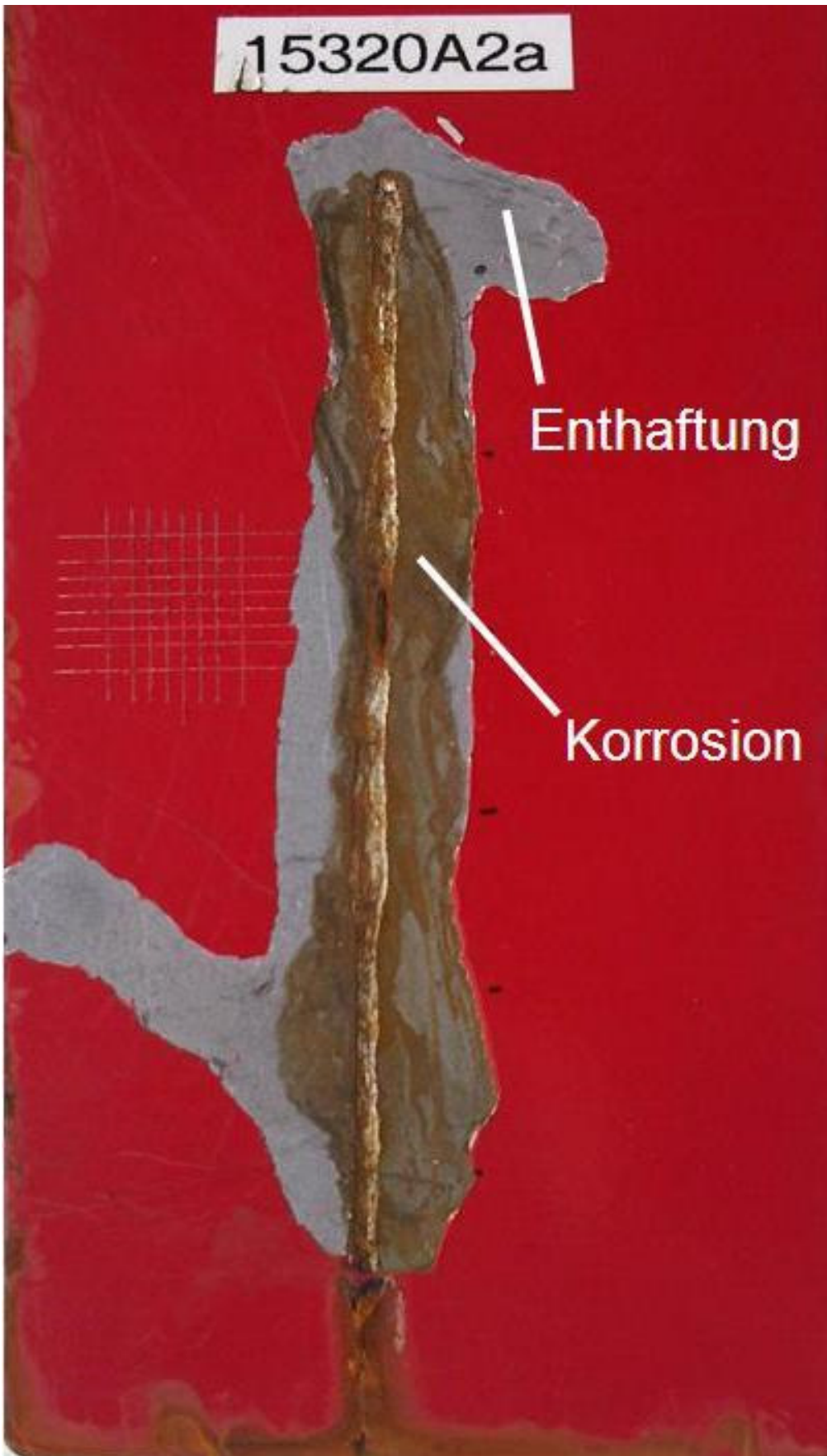
图 1：示例：腐蚀和油漆脱落
